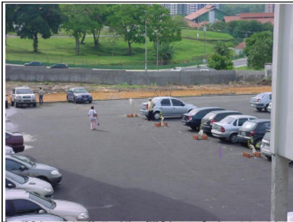
Figura 10 – Prolongamento da rua Maceió concluído, em 2008.
